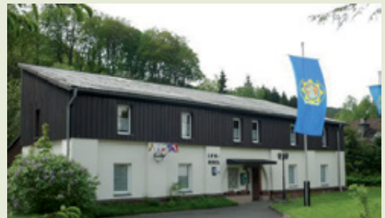
Das IPA-Haus Ramsbeck ist mit 17 Betten eines der größten deutschen IPA-Häuser
